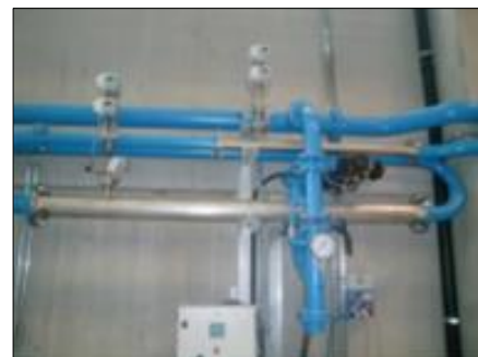
2 Messtecken (Edelstahl) DN 80 und DN 150 mit 2 Pöttersonden® und jeweils zwei dp-Transmittern
